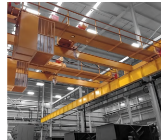
Dos grúas en la misma trabe
